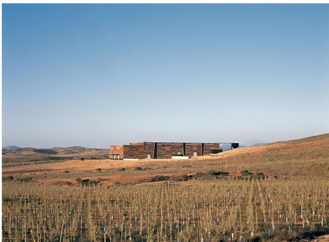
Рисунок 5 - Olisur: Olive Oil factory, г. Чили (Общий вид) [2]
