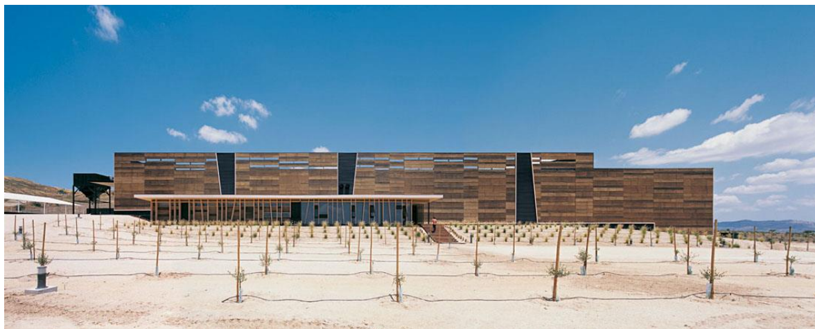
Рисунок 4 - Olisur: Olive Oil factory, г. Чили (Общий вид) [2]
